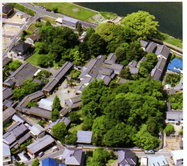
空からみた堀家
